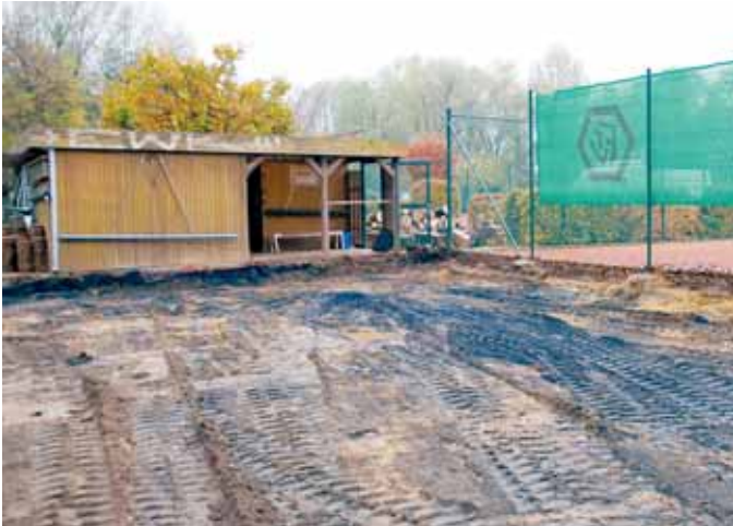
Blick auf die Baustelle des Midcourts am U-Bahn-Damm.
