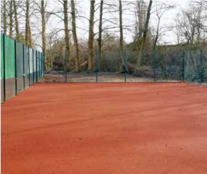
Der fertige Midcourt, es fehlen noch das Netz und die Linien.
