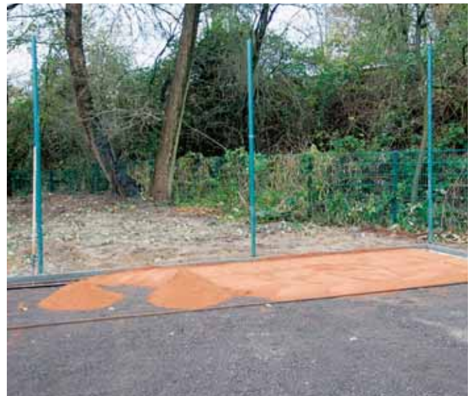
Auftragen und Planieren des Grandplatzbelags.
